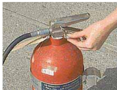
شکل ۱۳-۱- نحوه خارج کردن ضامن کپسول
