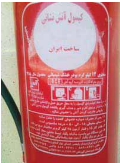
شکل ۱۱-۱- برچسب مشخصات کپسول
