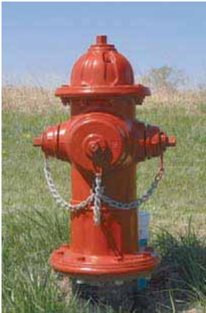
شکل ۱۶-۱ شیر آتش نشانی
